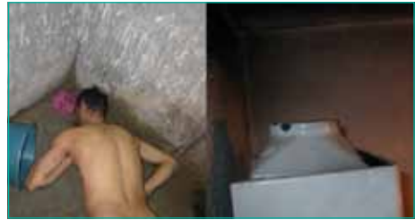
Resim 12: Bacası olmayan şofbenin bulunduğu banyoda CO zehirlenmesi sonucu ölen kişi ve şofbenin baca kısmının görünümü.
